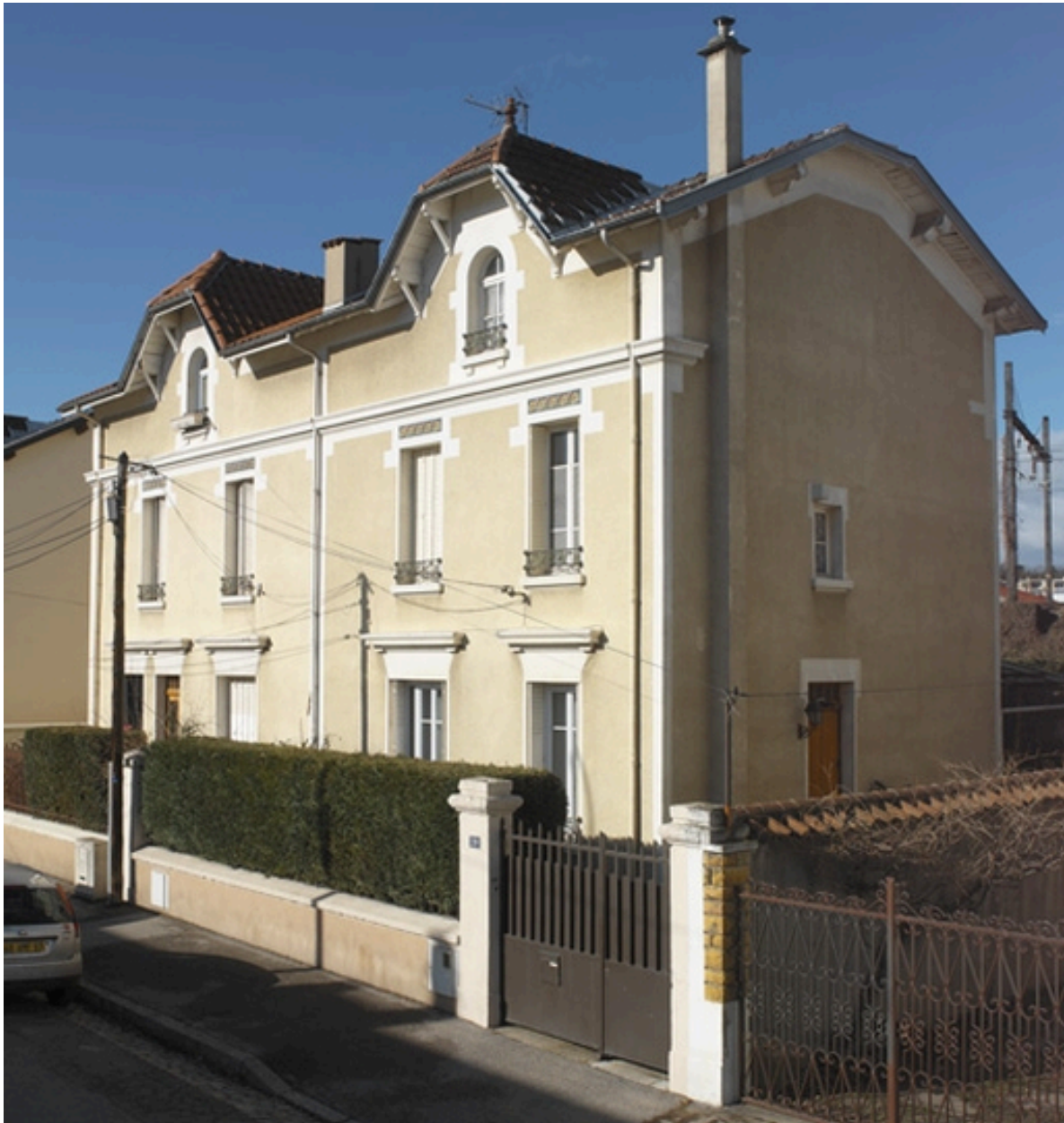
Vue nord-est, 20, 22 rue Littré (BP 42, 43), maison double pour père et fils, façade principale et entrée latérale nord-est pour l'une, et entrée façade principale sud-est pour l'autre
