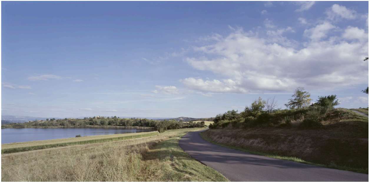
Vue générale de l'étang, depuis le nord-ouest.
