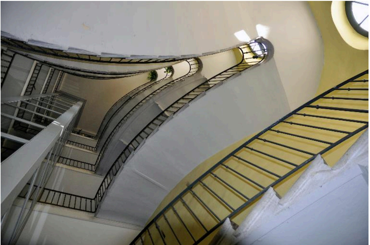
Vue de la cage d'escalier, prise en contre-plongée
