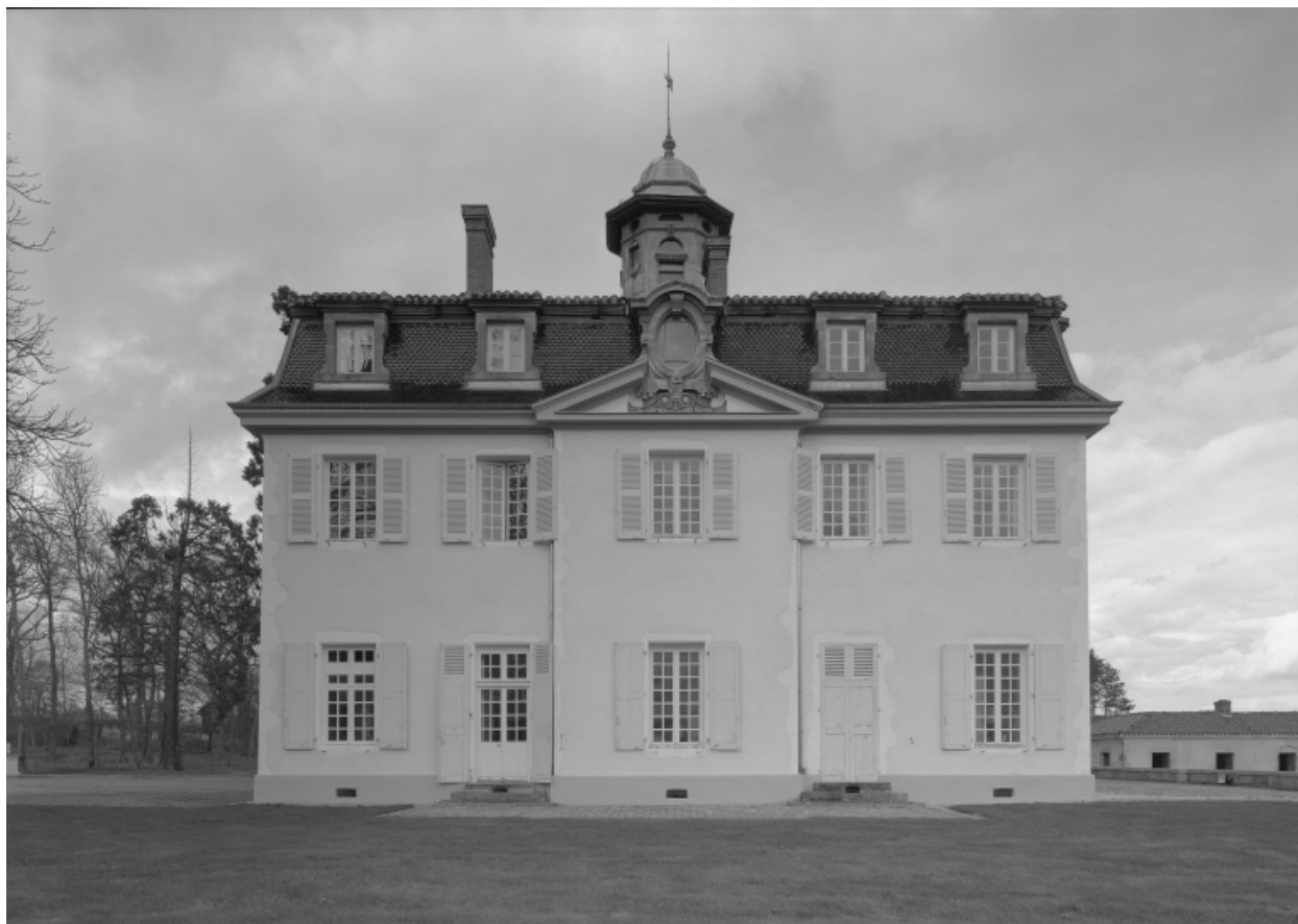
Vue générale de la façade sud du château, du sud.
