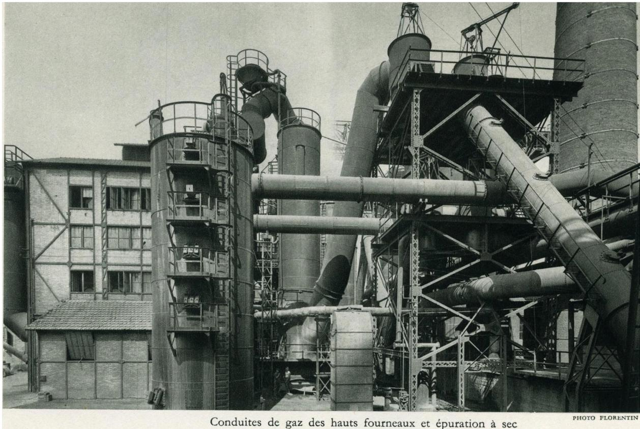
Conduites de gaz des hauts fourneaux et épuration à sec
