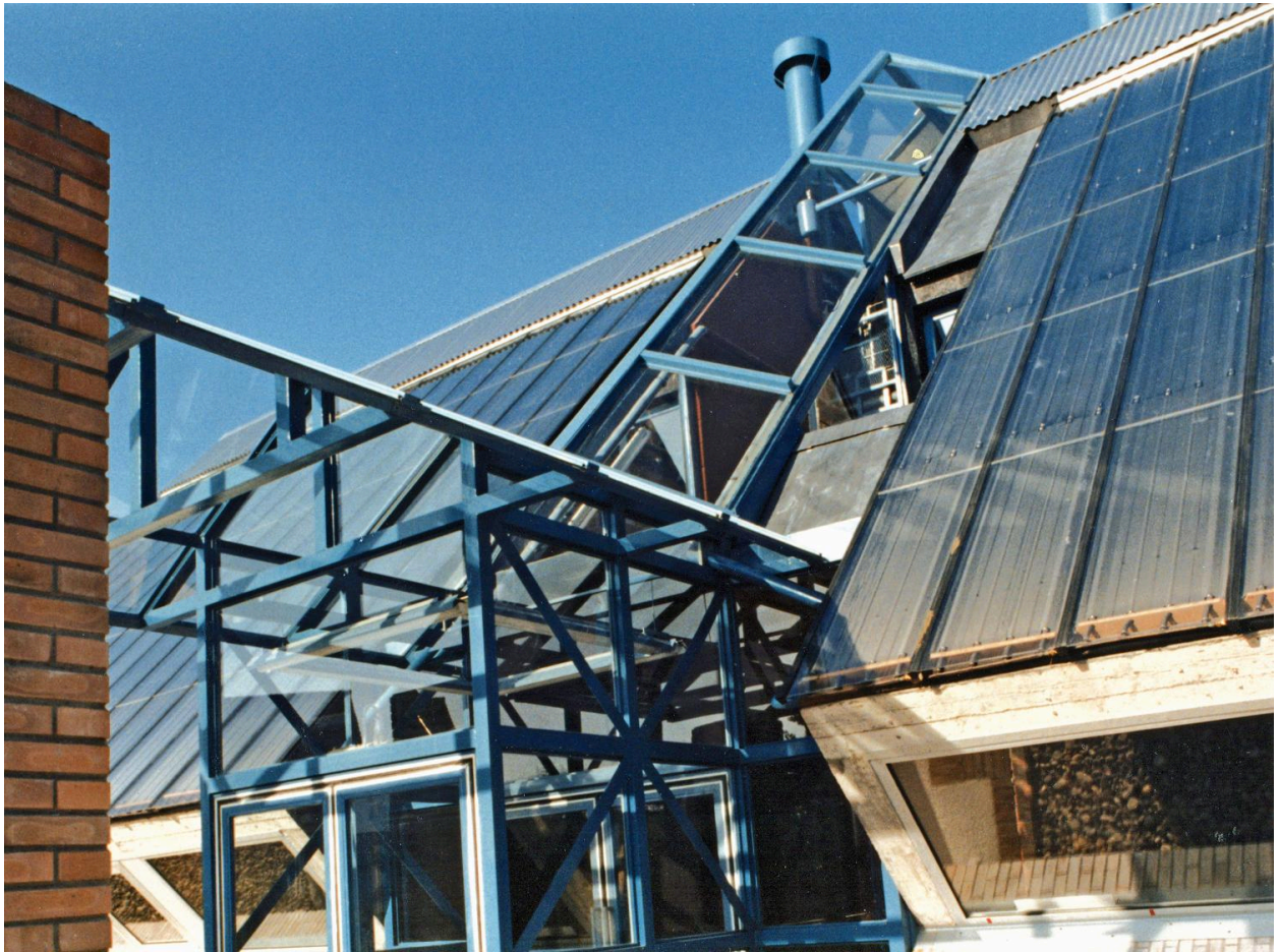
Billom, subdivision de la DDE, détail des capteurs solaires, détail de la verrière au-dessus du porche et du vestibule, ainsi que sur le pan incliné de la façade sud, état initial, 1983, archives privées J.-P. Reuillard.
