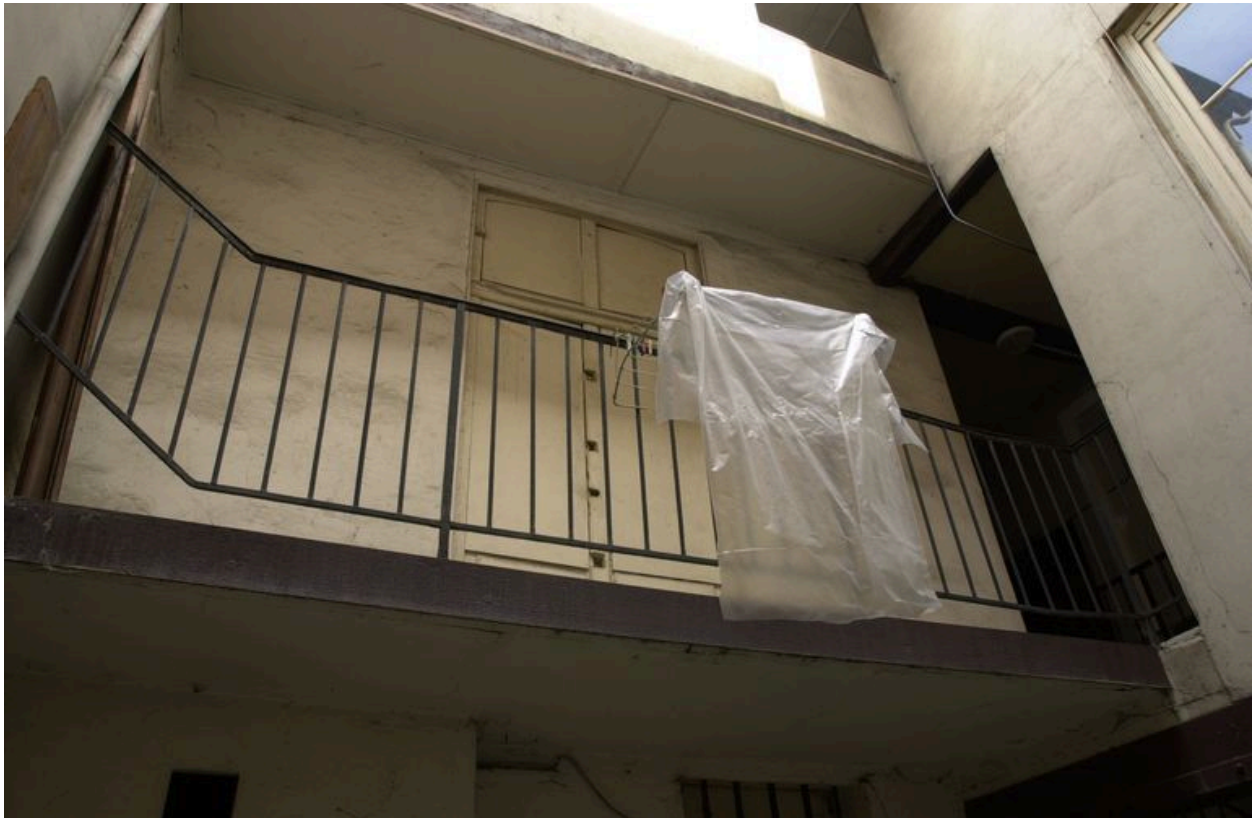
Vue de la coursière du 1er étage, élévation postérieure
