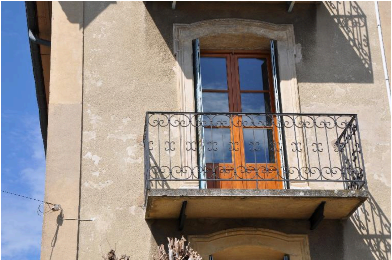
Détail sur la baie du 1er étage du mur-pignon sud
