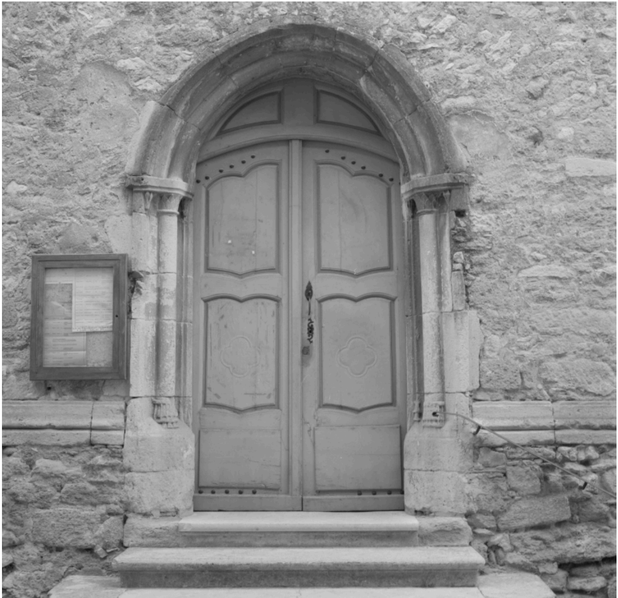
Façade, détail : portail d'entrée.
