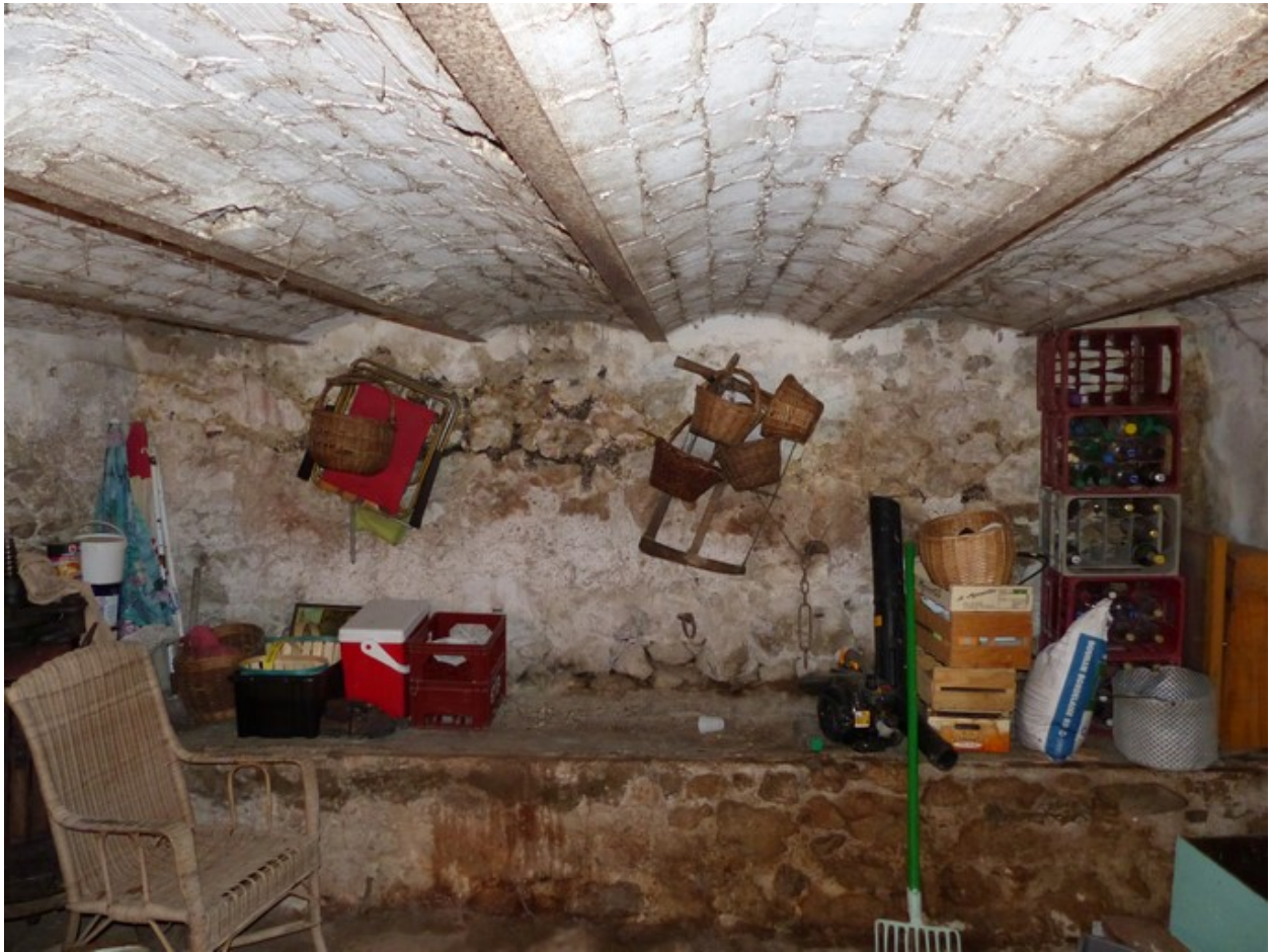
Etage de soubassement, étable ouest. Vue de volume prise du nord.
