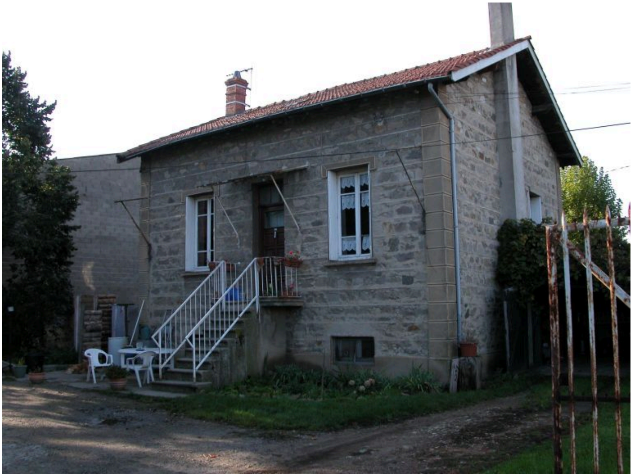
Reclava (la), Usines abandonnée AI 205, 206. Vue d'ensemble de la maison de gardien d'usine.
