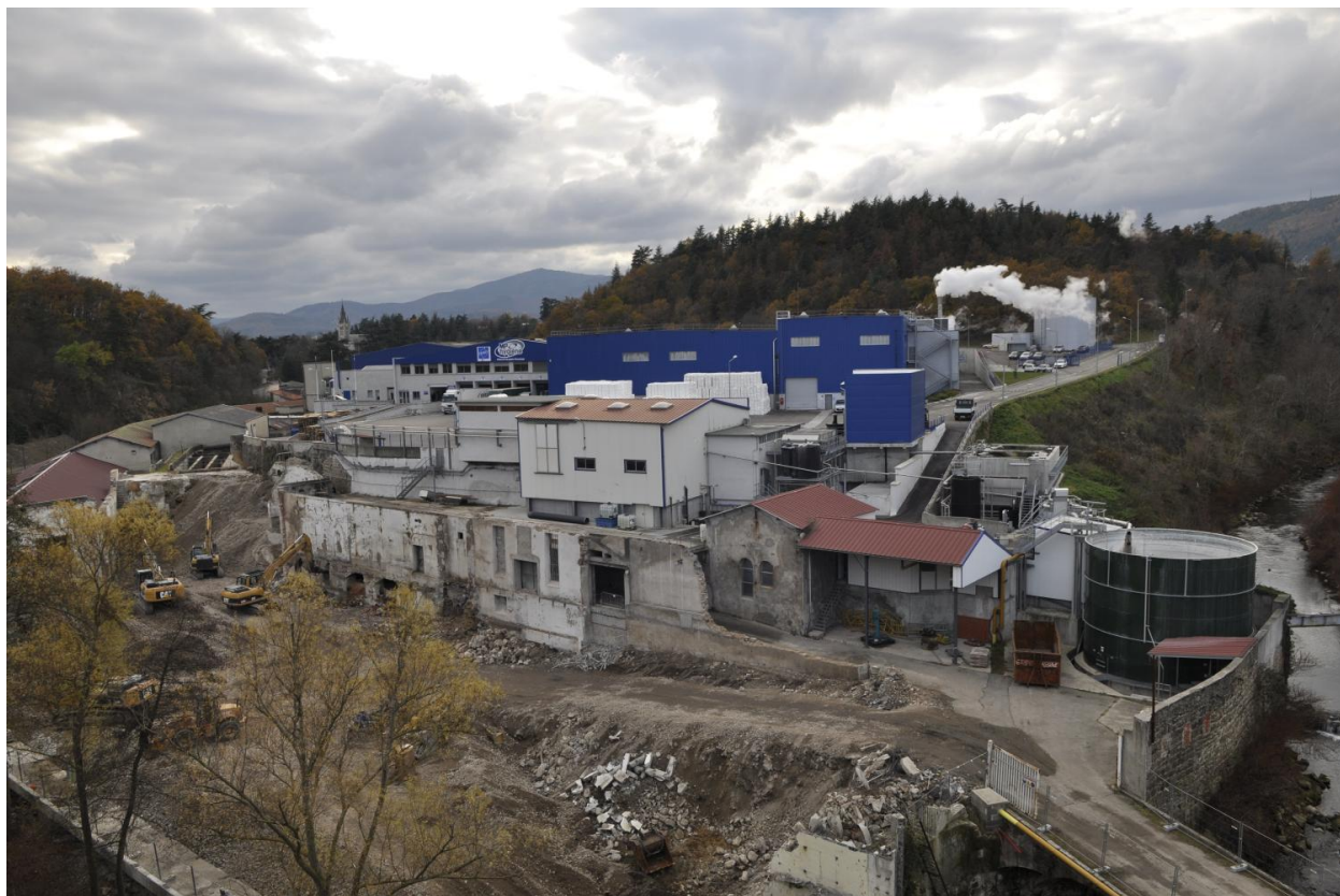
Vue nord du site : nouvelle usine
