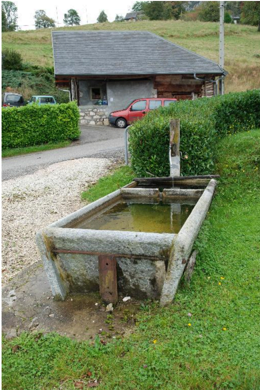
Corbières (les), bassin-fontaine, 2014 B6 716. Vue d'ensemble du bassin en pierre.
