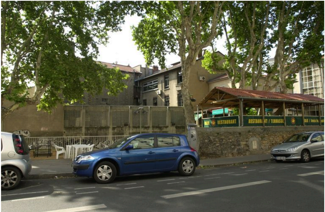
Elévation postérieure, vue depuis l'est
