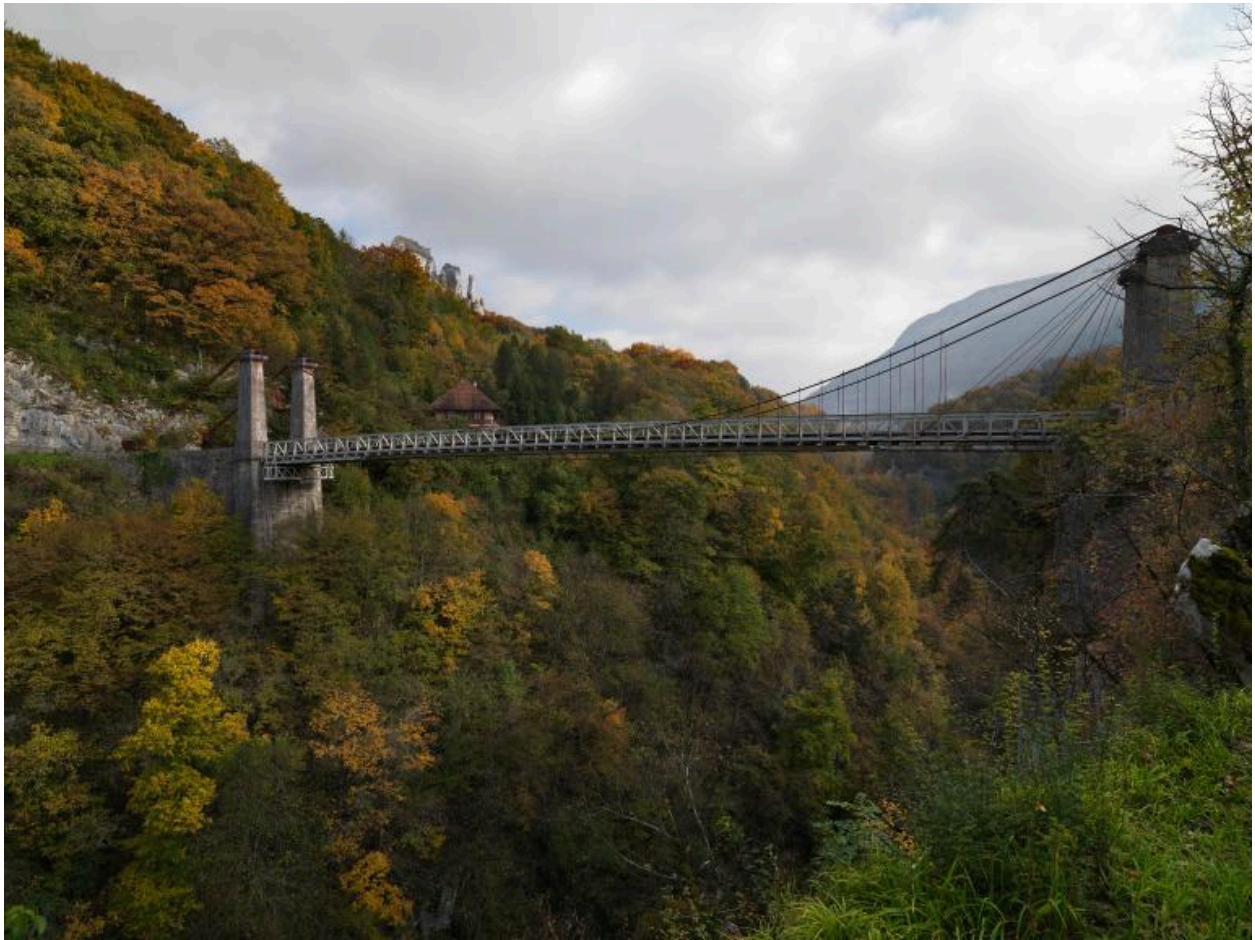
Vue d'ensemble du pont suspendu depuis Cusy.
