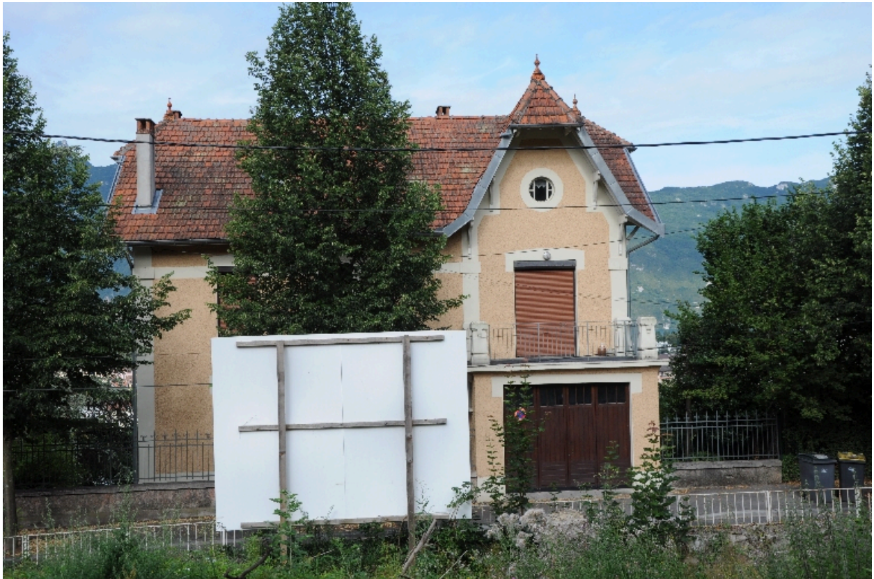
Vue générale, façade sur rue
