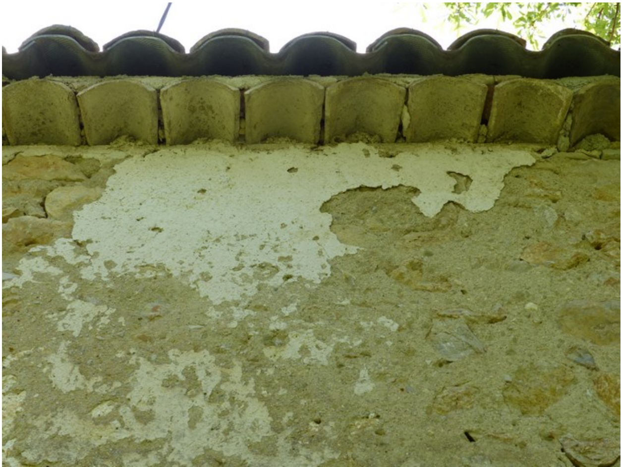
Elévation ouest, détail de l'enduit.
