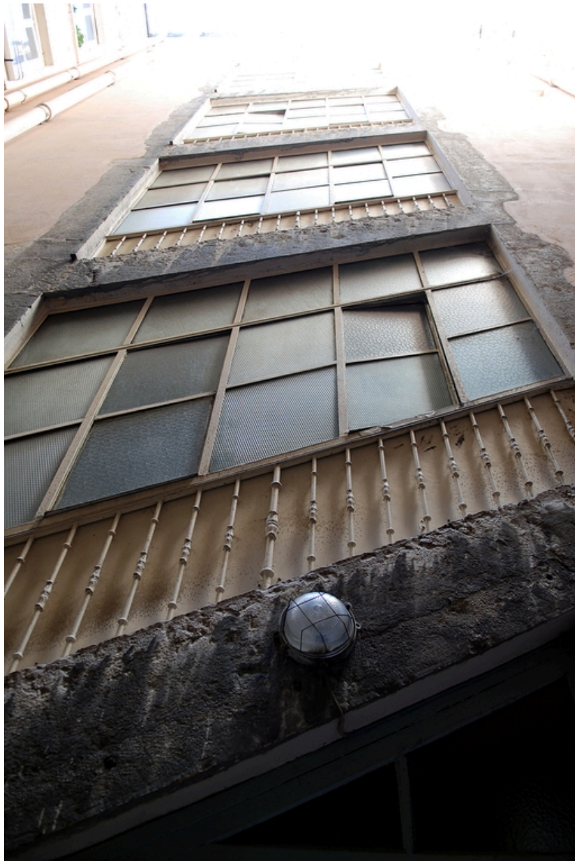
Elévation sur cour : la travée d'escalier
