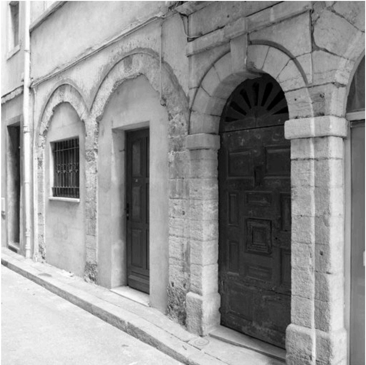
Façade sur rue, porte et les deux arcades de boutique à gauche
