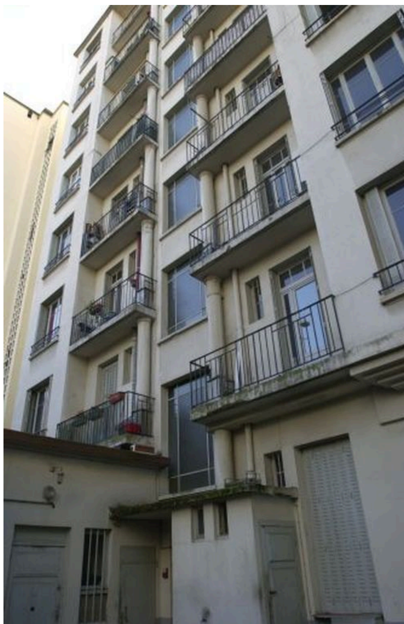
Vue rapprochée de la façade postérieure
