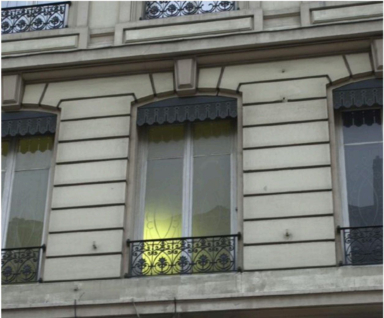
Détail de la fenêtre de l'entresol
