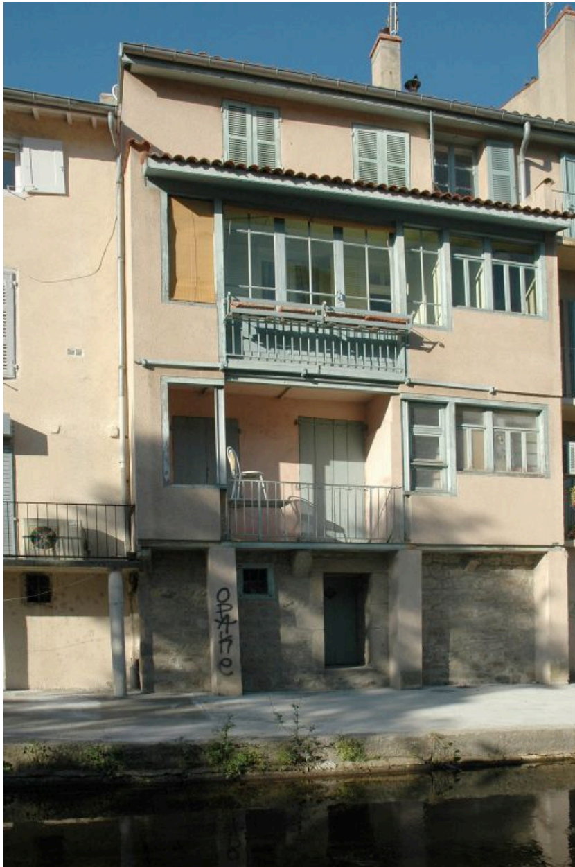
Elévation postérieure du côté de la rivière.
