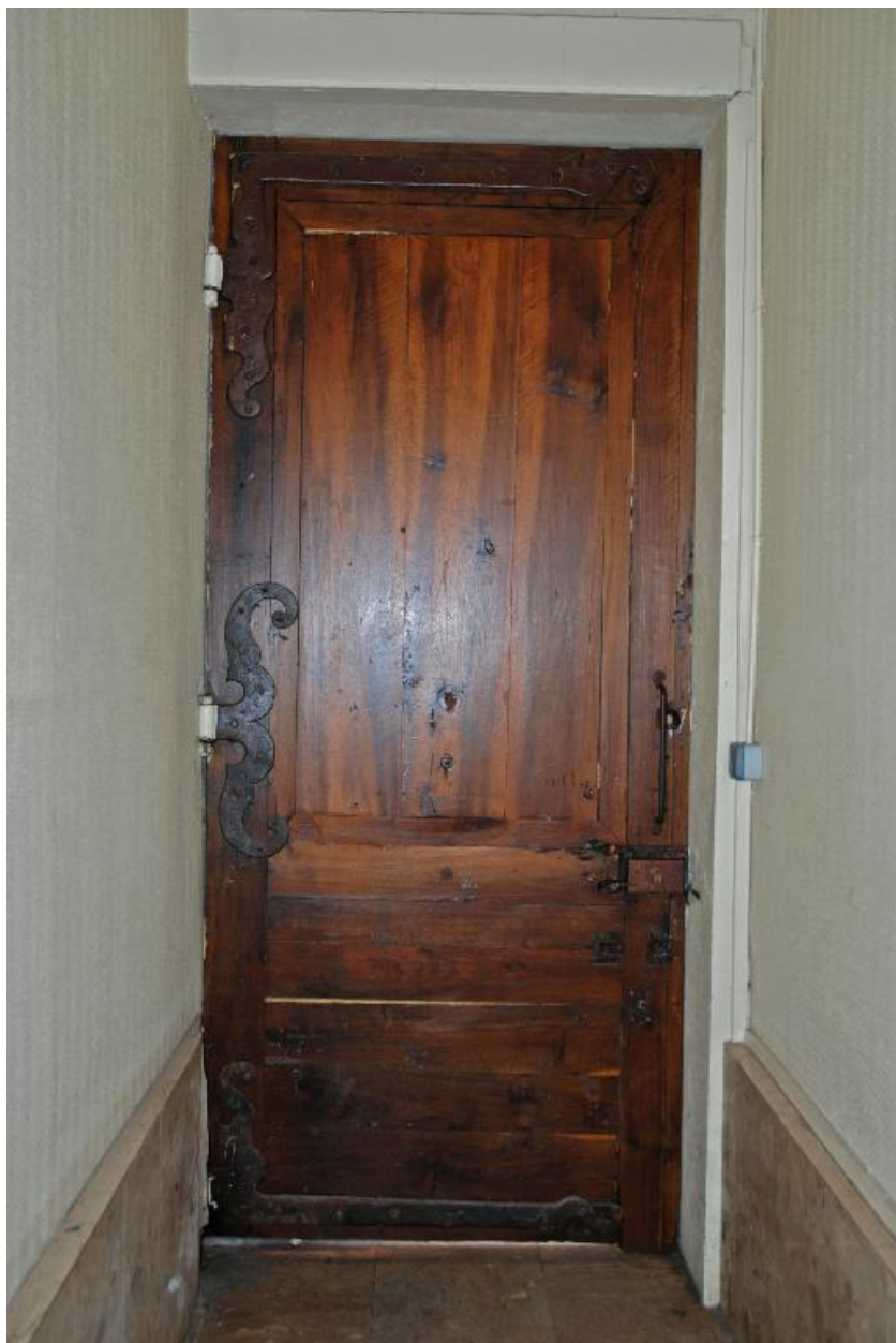
Revers de la porte piétonne, menuiserie et pentures
