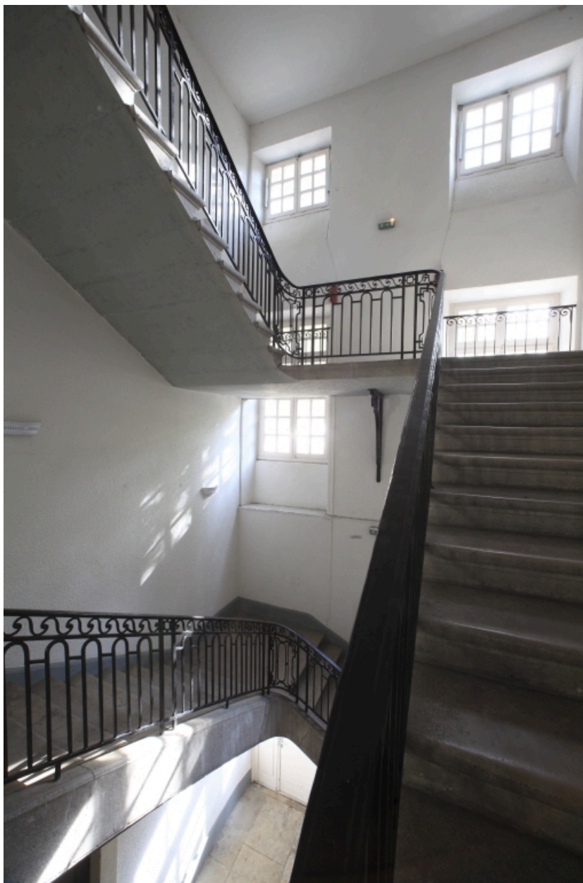
Bâtiment C. Escalier C, vue entre le 1er étage et le palier intermédiaire menant au second.
