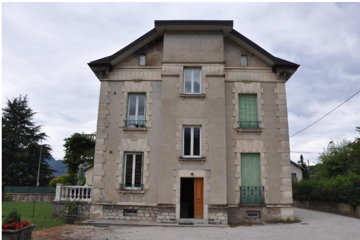
Façade latérale est
