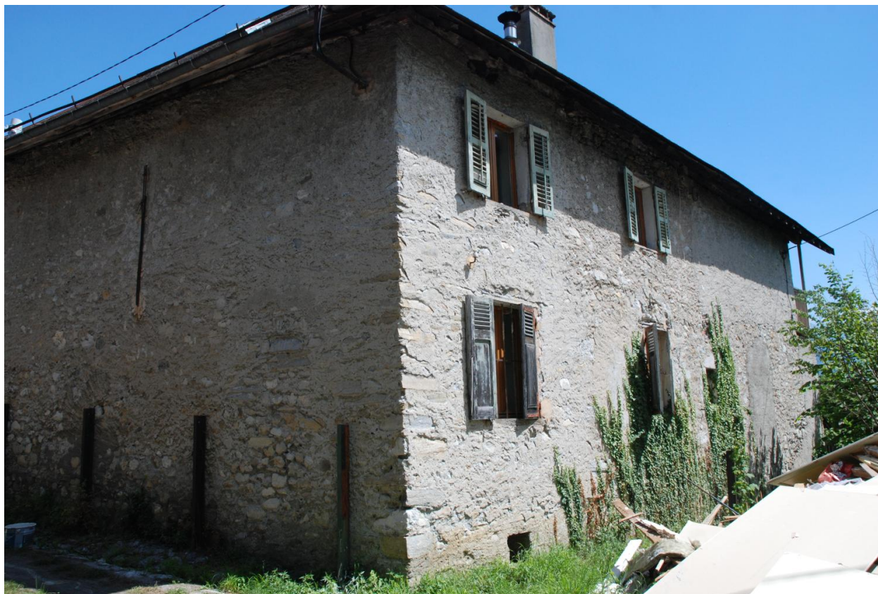
Maison de vigneron (2018 I1 191), vue arrière.
