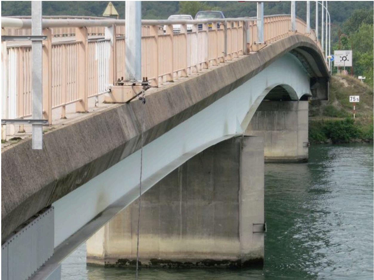
Vue partielle, de côté, tablier et parapet, face amont (depuis la rive gauche)
