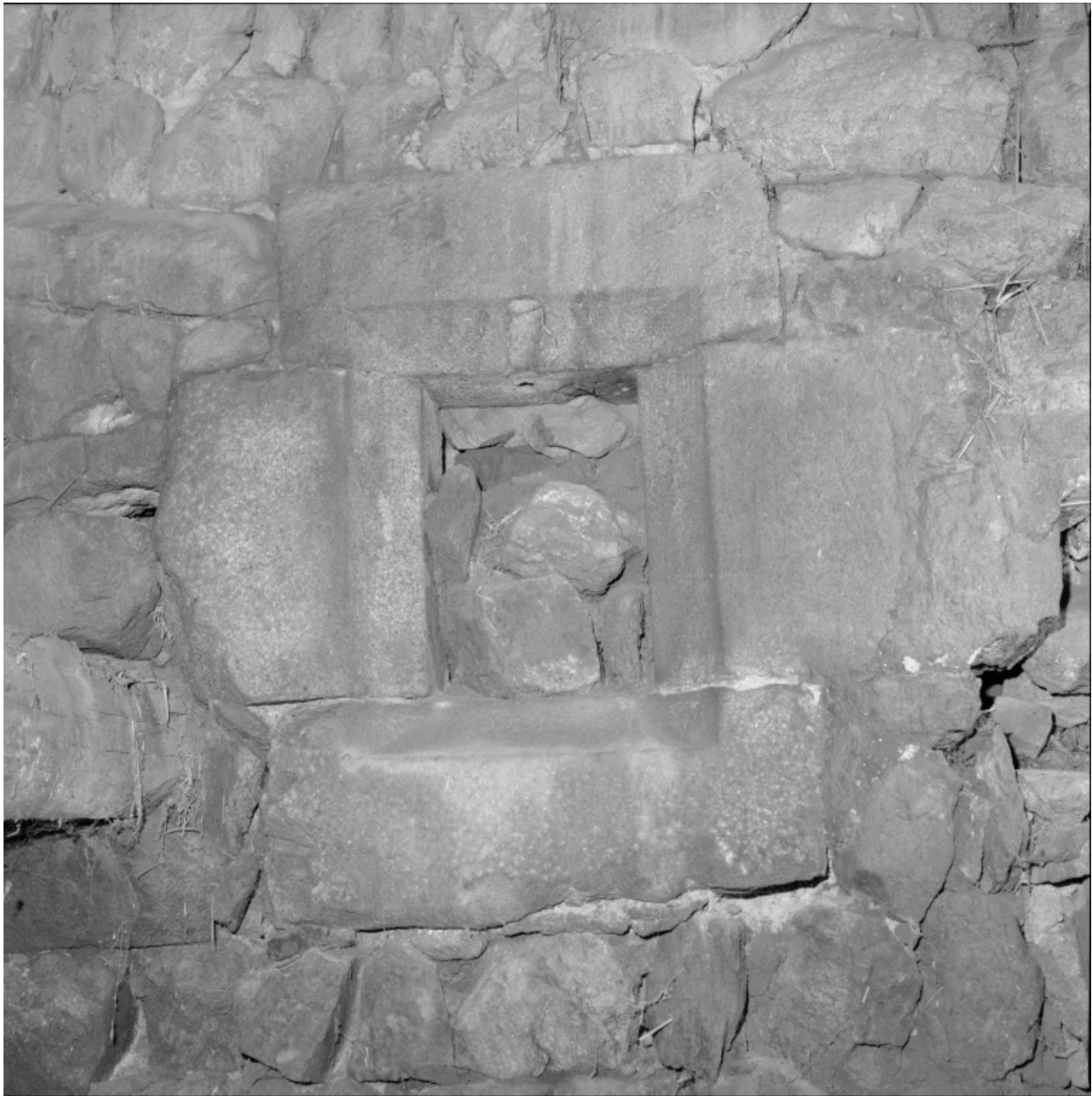
Intérieur du logis, détail d'une baie à encadrement chanfreiné, murée.
