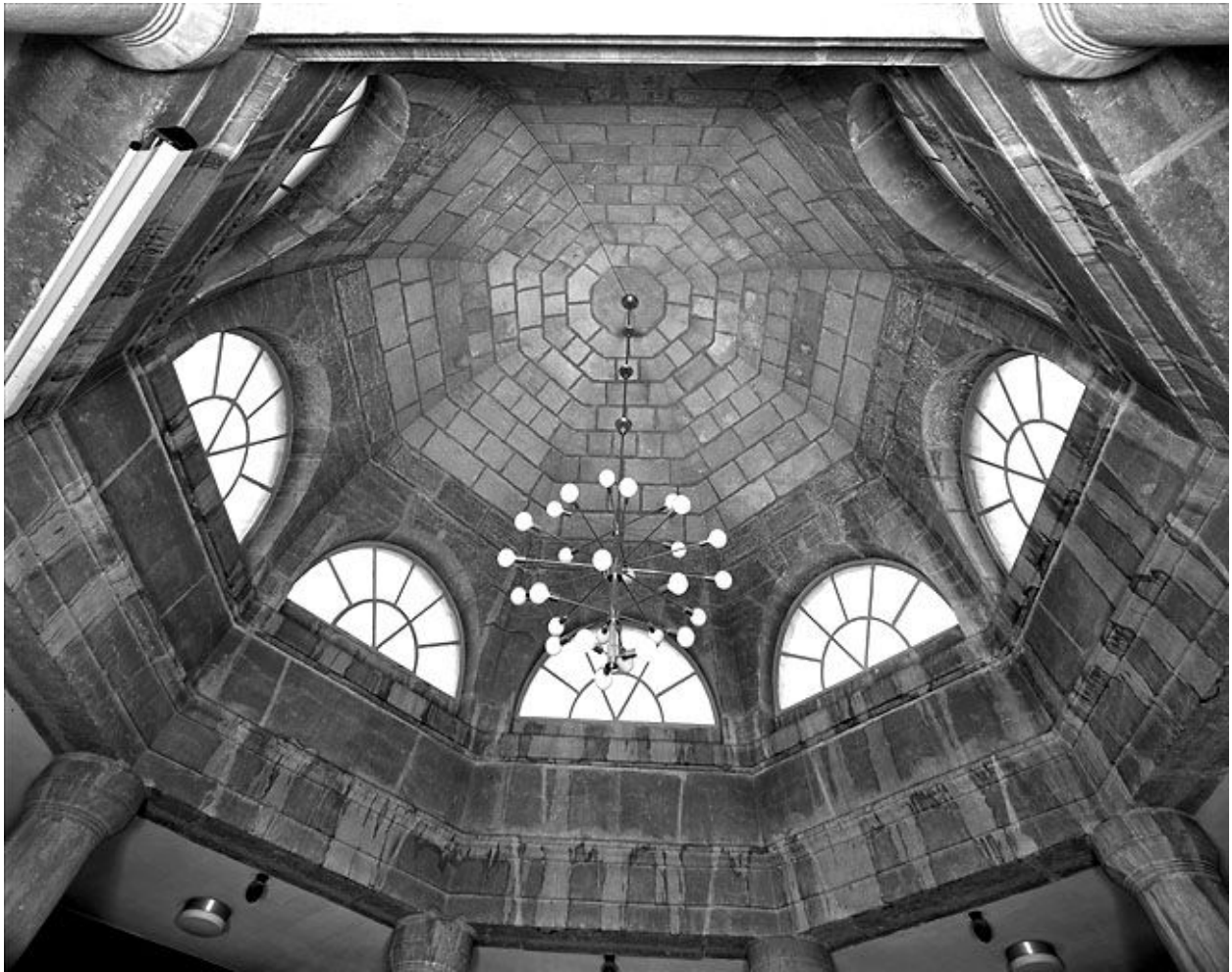
Coupoles de l'ancienne chapelle
