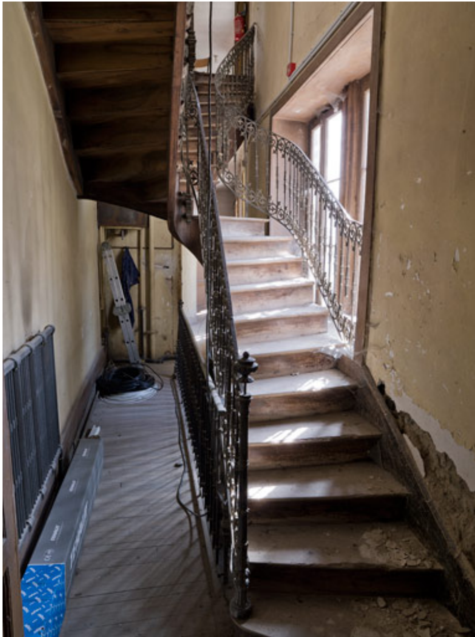
Escalier intérieur, vue de la 1ère volée droite.
