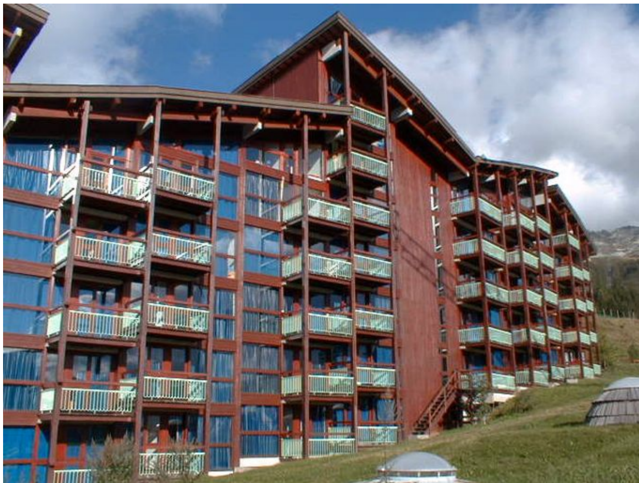
Façade ouest (aval)
