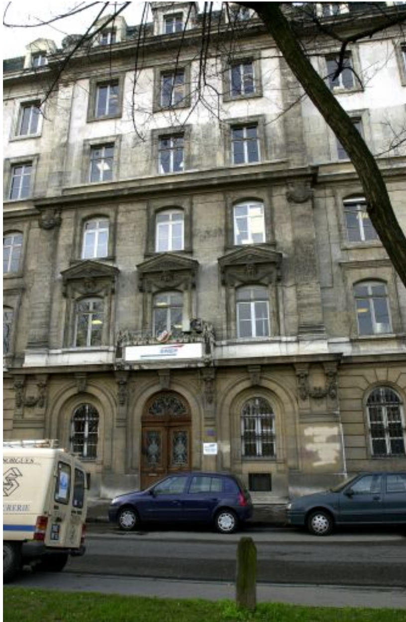
Détail des travées centrales
