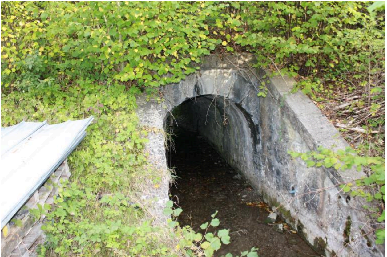
Ponceau de la Glière, face aval
