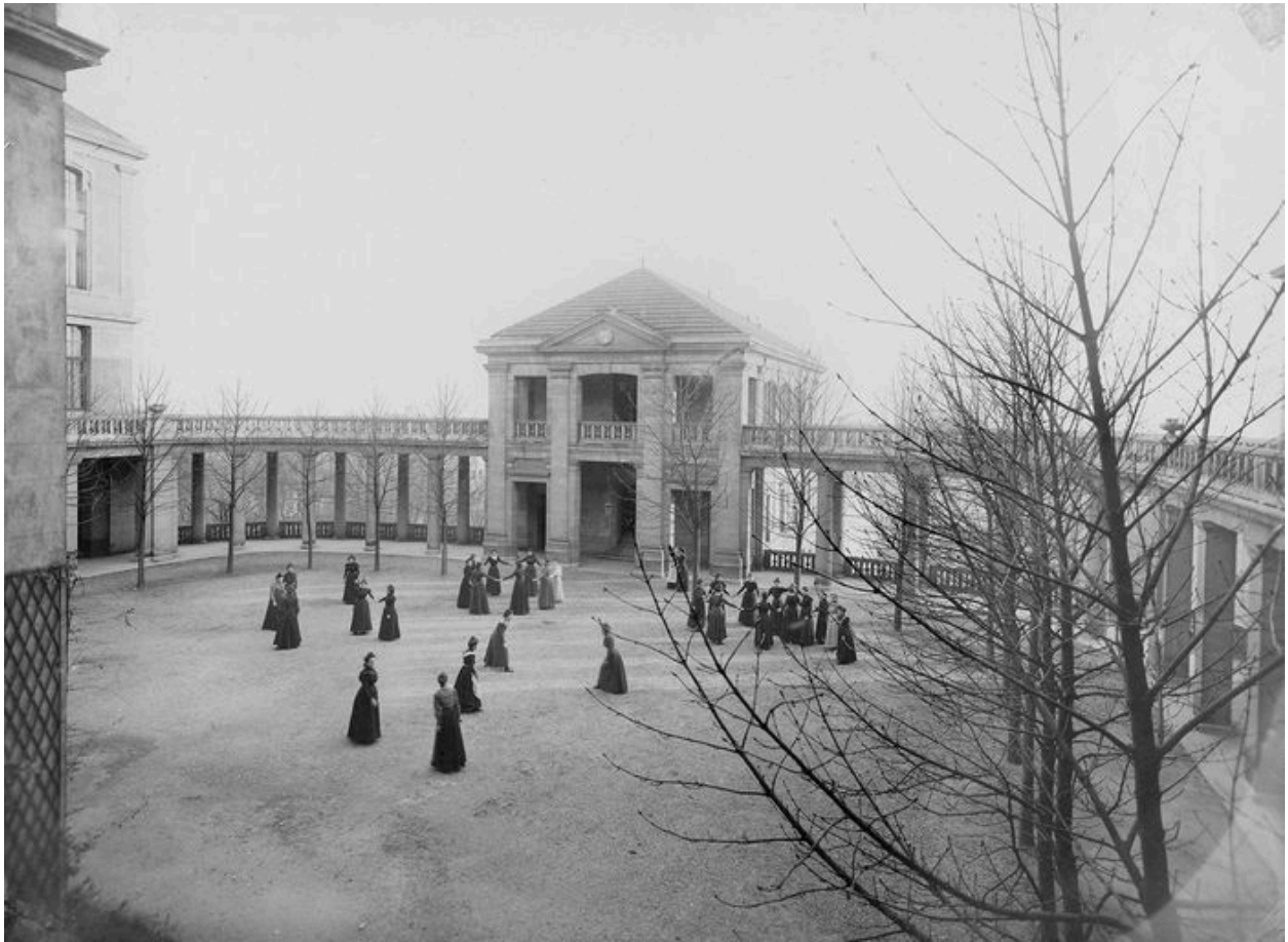
Vue de la cour de l'étage des préaux, de l'amphithéâtre et de la galerie avec ses balustres et garde-corps encore en pierre (Arch. dép. Rhône, 1 T 1275, photographie).
