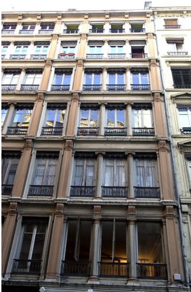
Façade, détail de l'élévation
