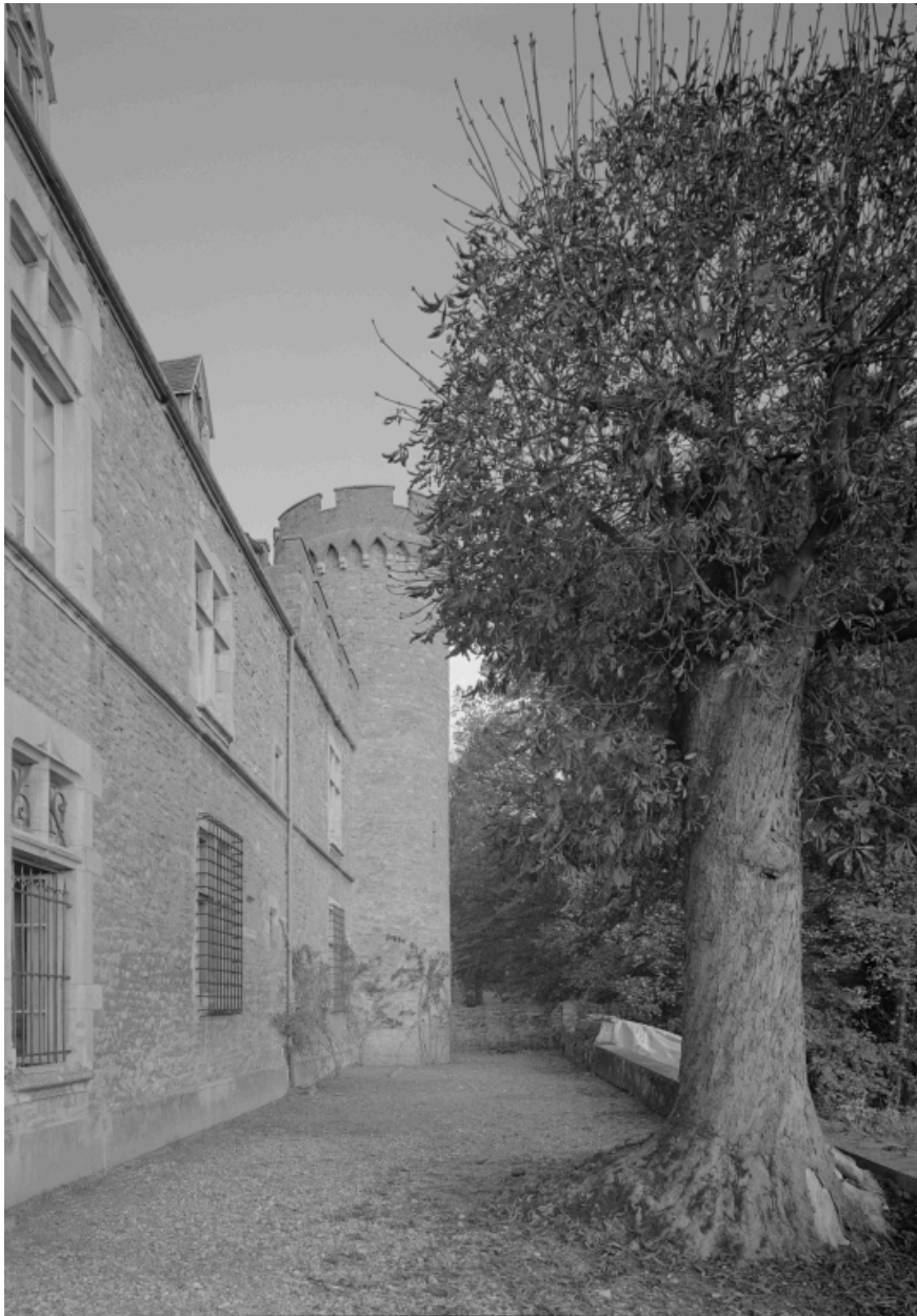
Aile sud, élévation postérieure sur terrasse.
