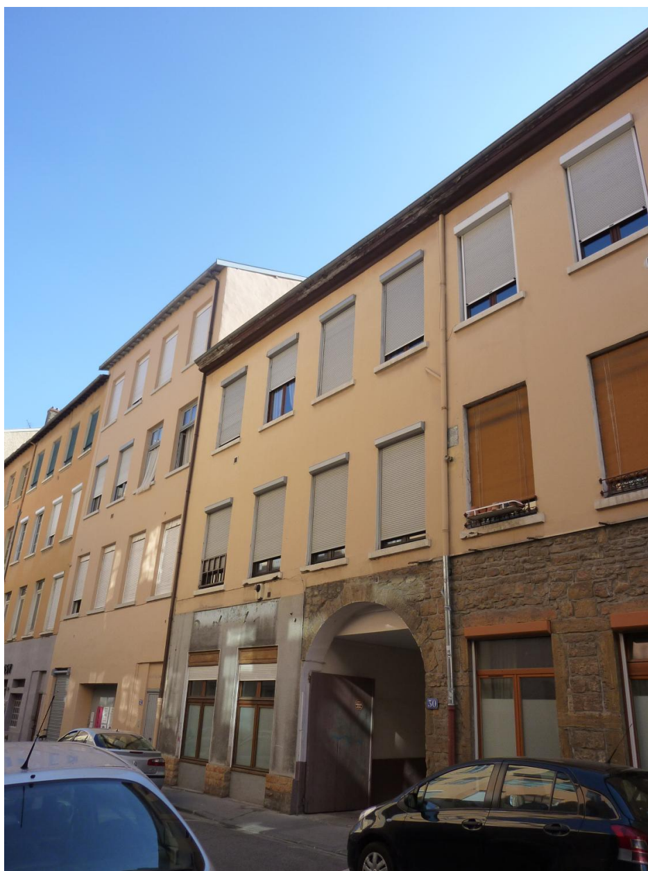
Vue d'ensemble de l'immeuble du 30 rue du mail
