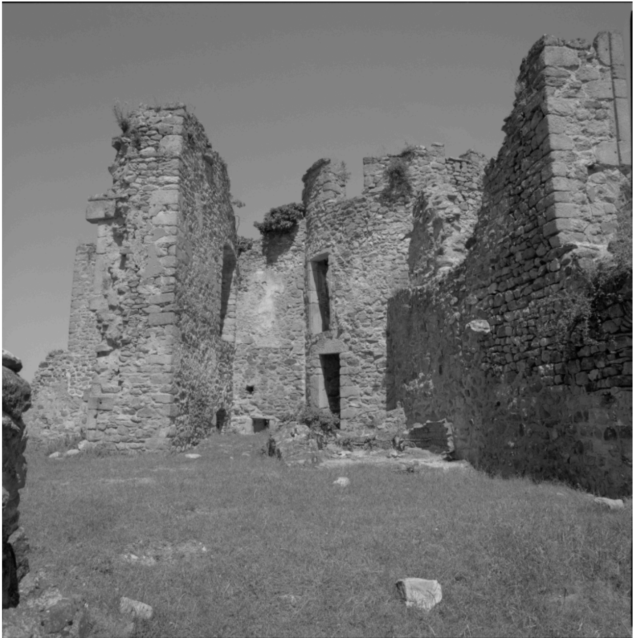
Premier baile, partie nord : vue intérieure ruinée située dans l'angle nord de la première enceinte ; vue du four au premier plan et de la tour ronde (tour n°10 du plan), du sud-est.
