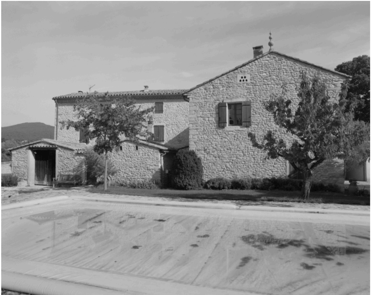
Elévations sud, vue d'ensemble.
