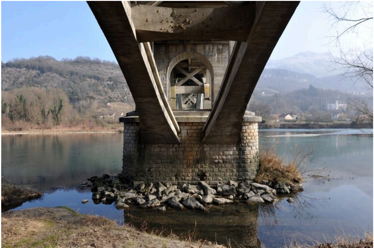
Vue générale, de dessous (depuis la rive droite)
