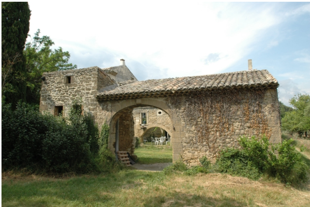
Vue sud du porche d'entrée
