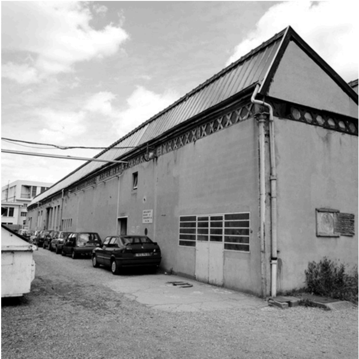
Détail shed et structure métallique
