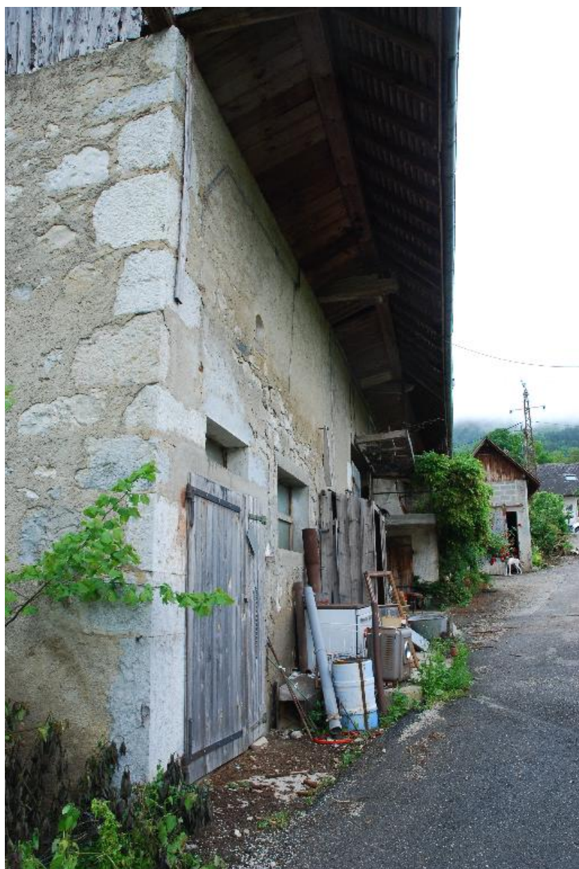
Vue de la façade en enfilade depuis l'ouest.
