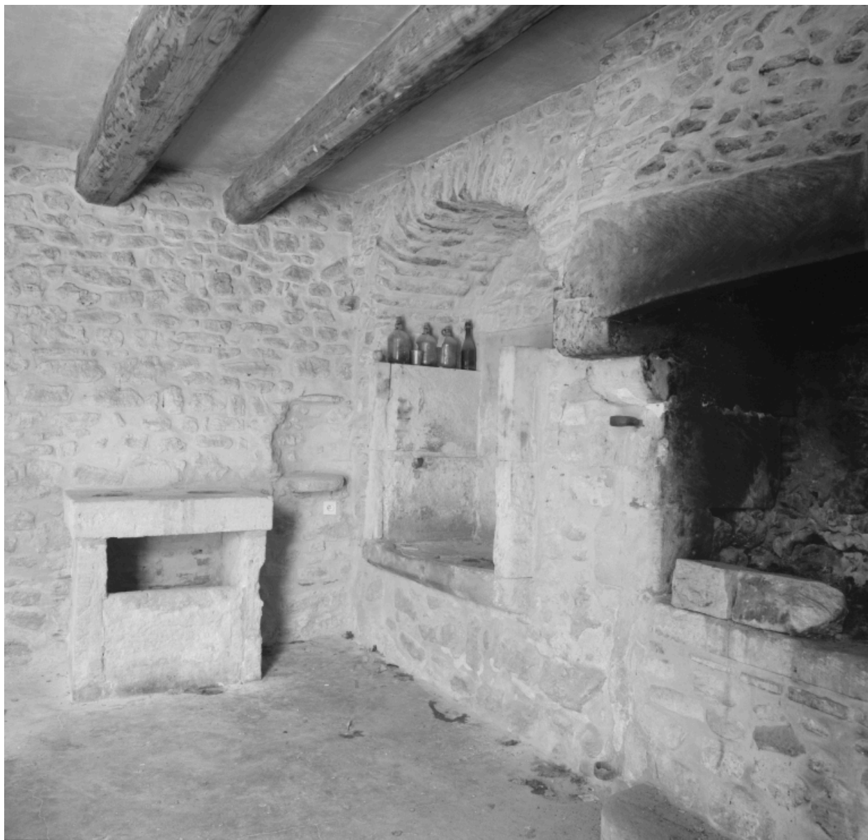
Ancien logis du Grand Cordy, vue partielle de l'aménagement intérieur de la salle : cheminée, évier et potager.
