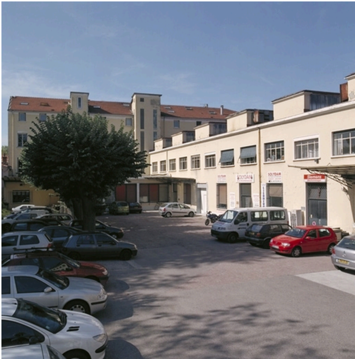
Vue sud des anciens ateliers
