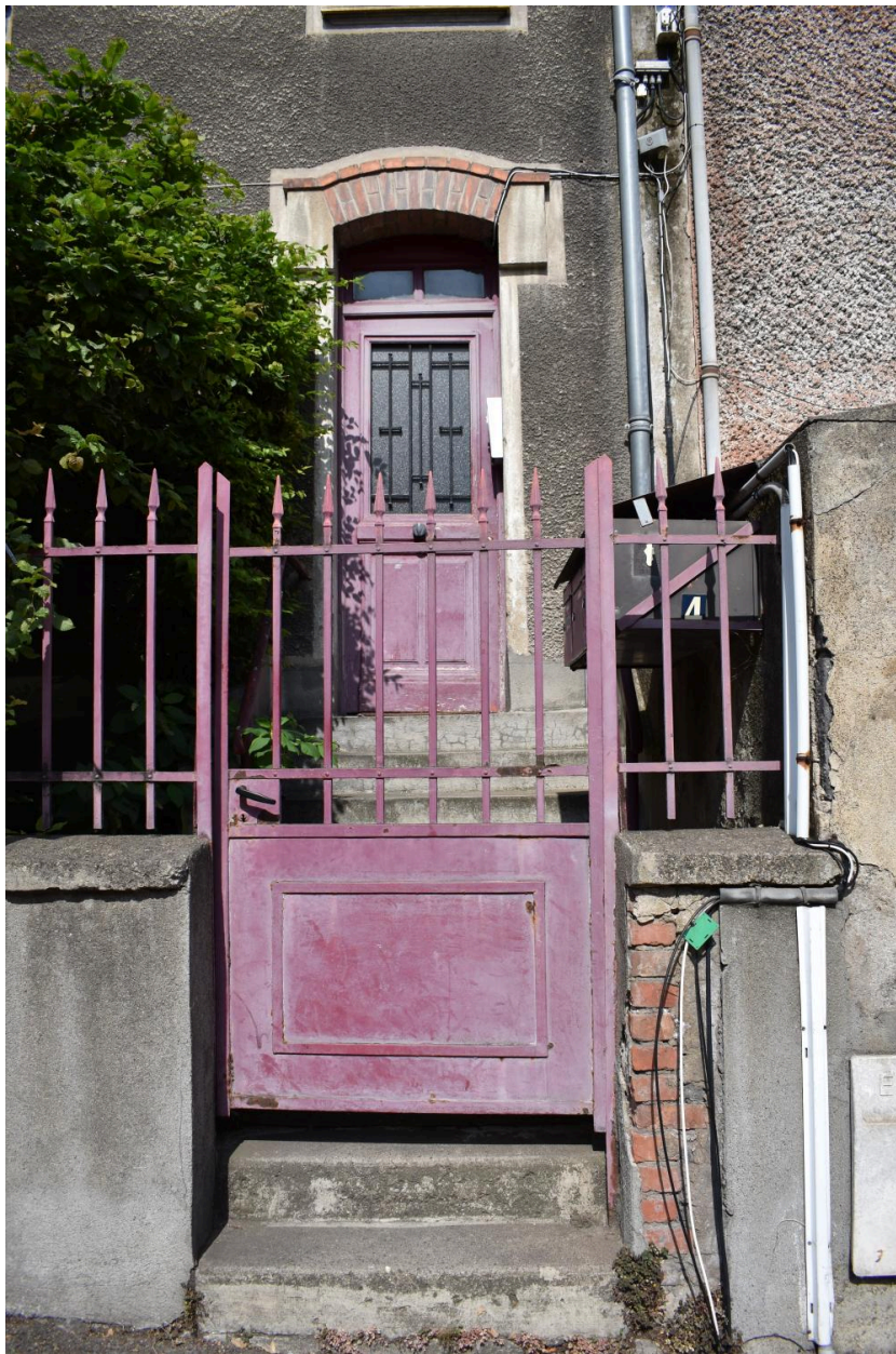
Porte d'entrée desservant les étages
