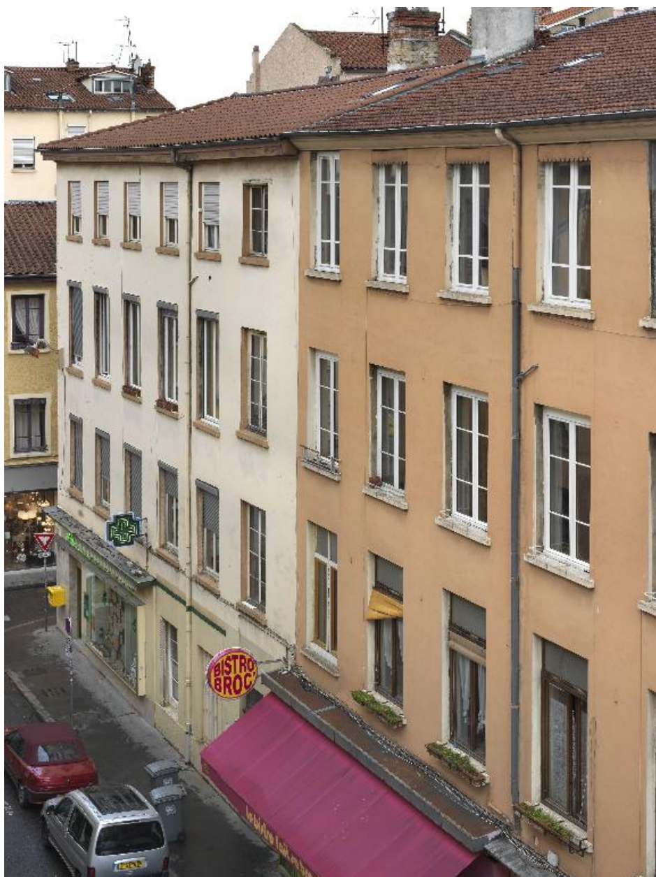
Vue d'ensemble du n°1 rue Dumenge
