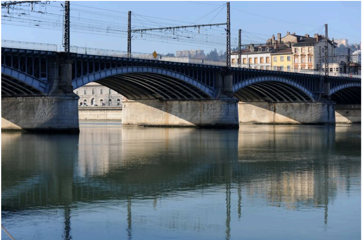
Vue partielle, travées centrales, face amont (depuis la rive gauche)
