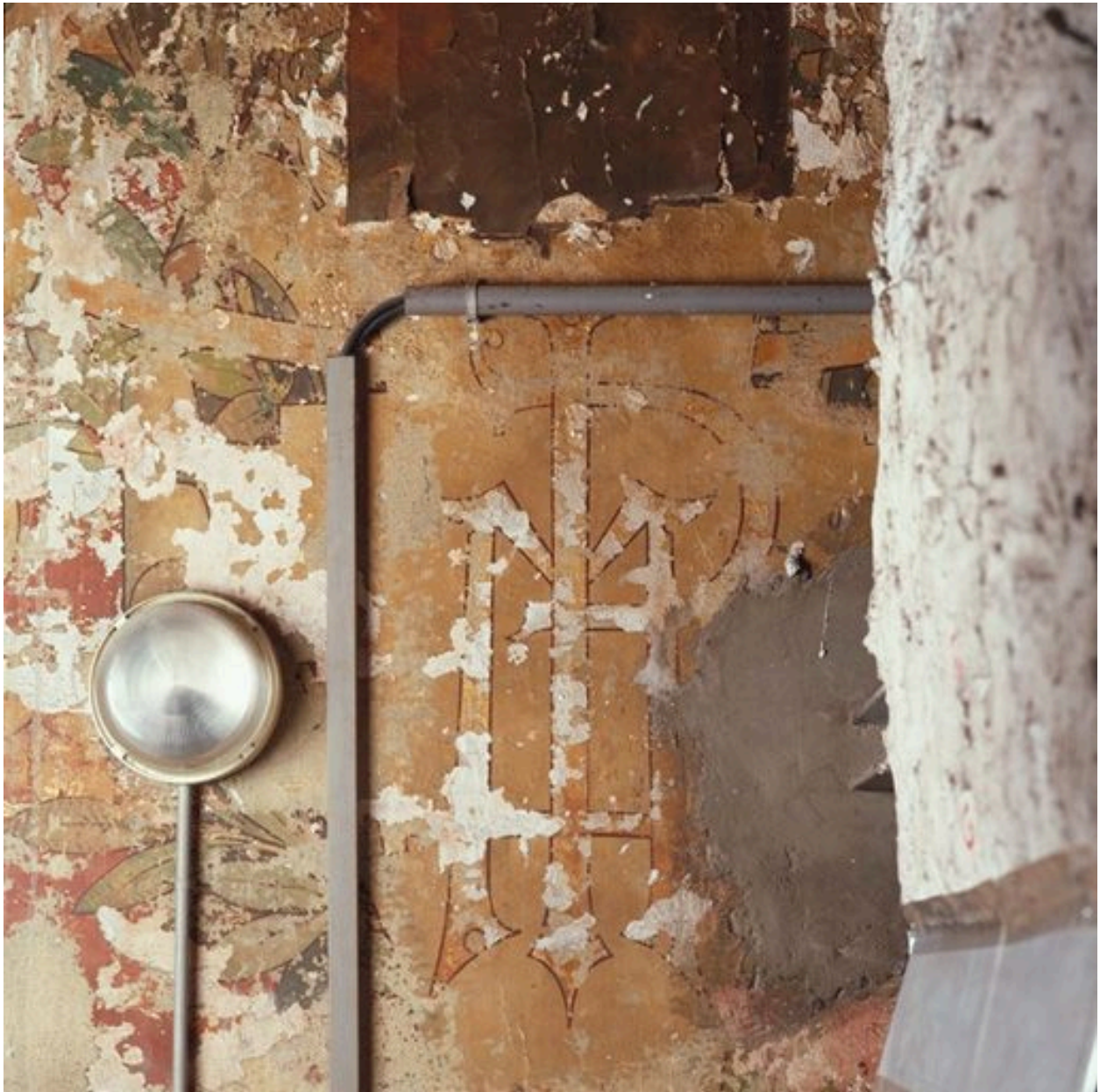
Le bâtiment-voyageurs : buffet, lettres PLM peintes sur enduit
