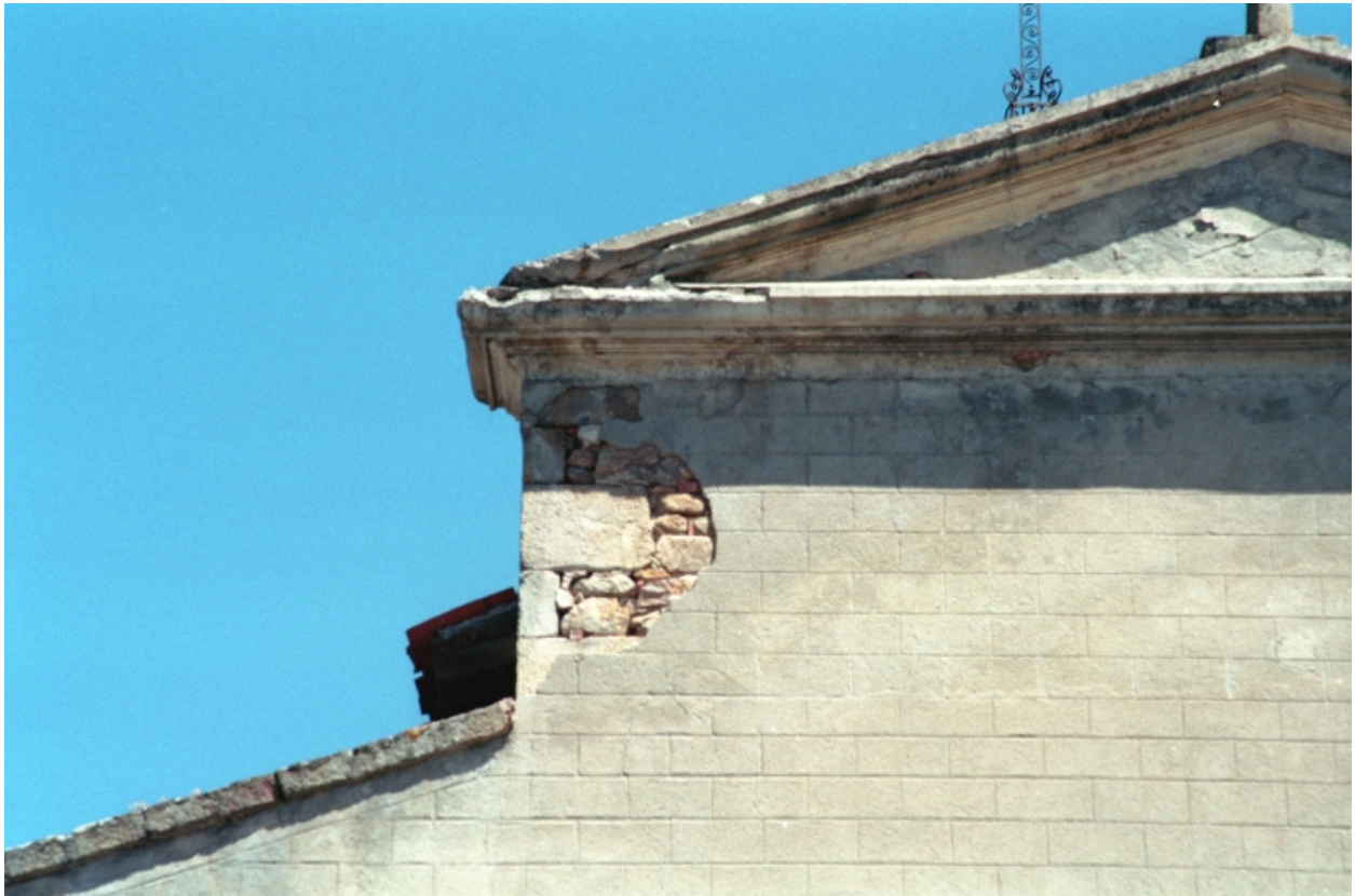
Détail des matériaux de construction de la façade, en partie haute.
